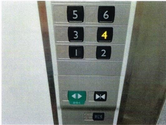
4号館エレベーター点字
