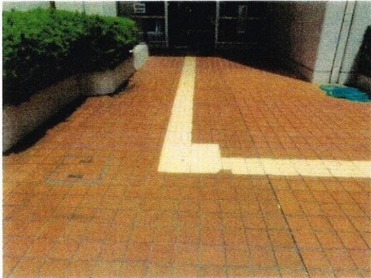
1号館前点字ブロック
